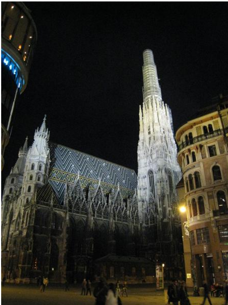
やっと修復が終わって塔が見えるようになったシュテファン大聖堂の夜の風景。 ウィーン編、続く。(かな?)
