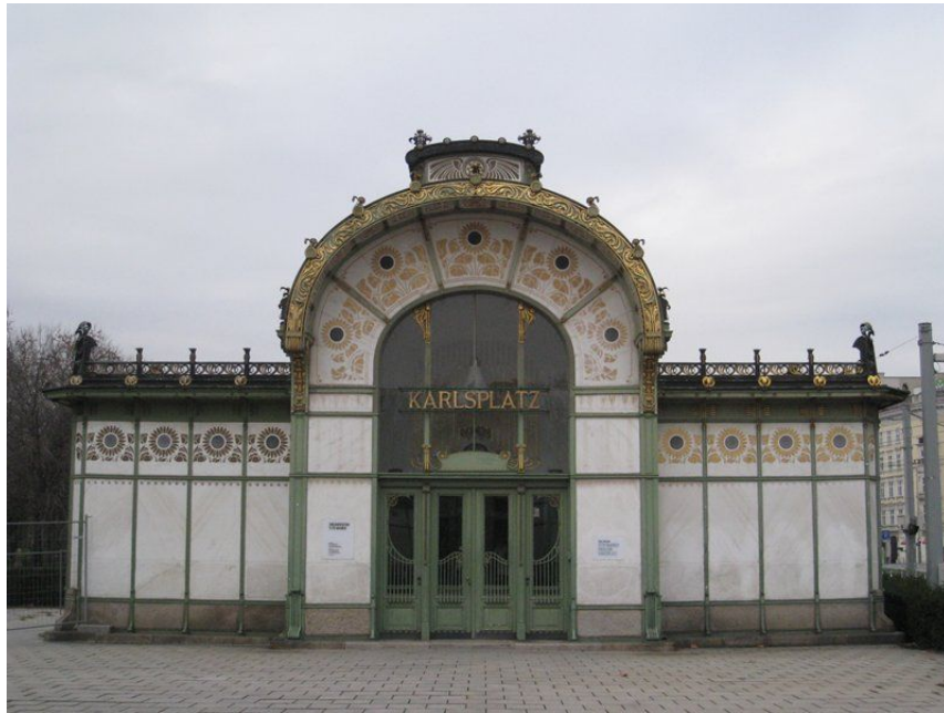
Karlsplatz 駅の旧駅舎
