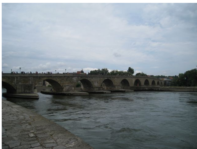
ドナウ河と石の橋。豊かな水量で、流れも速いです。
