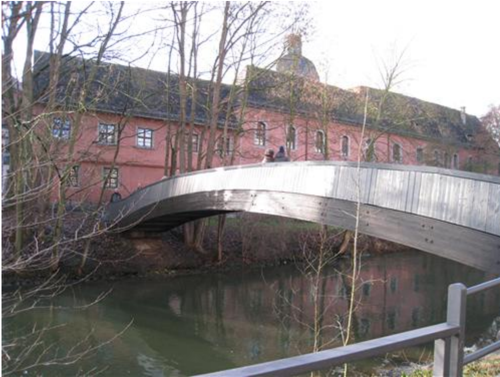
途中で見かけた、いい感じの風景+この橋は、結構急傾斜でした。
